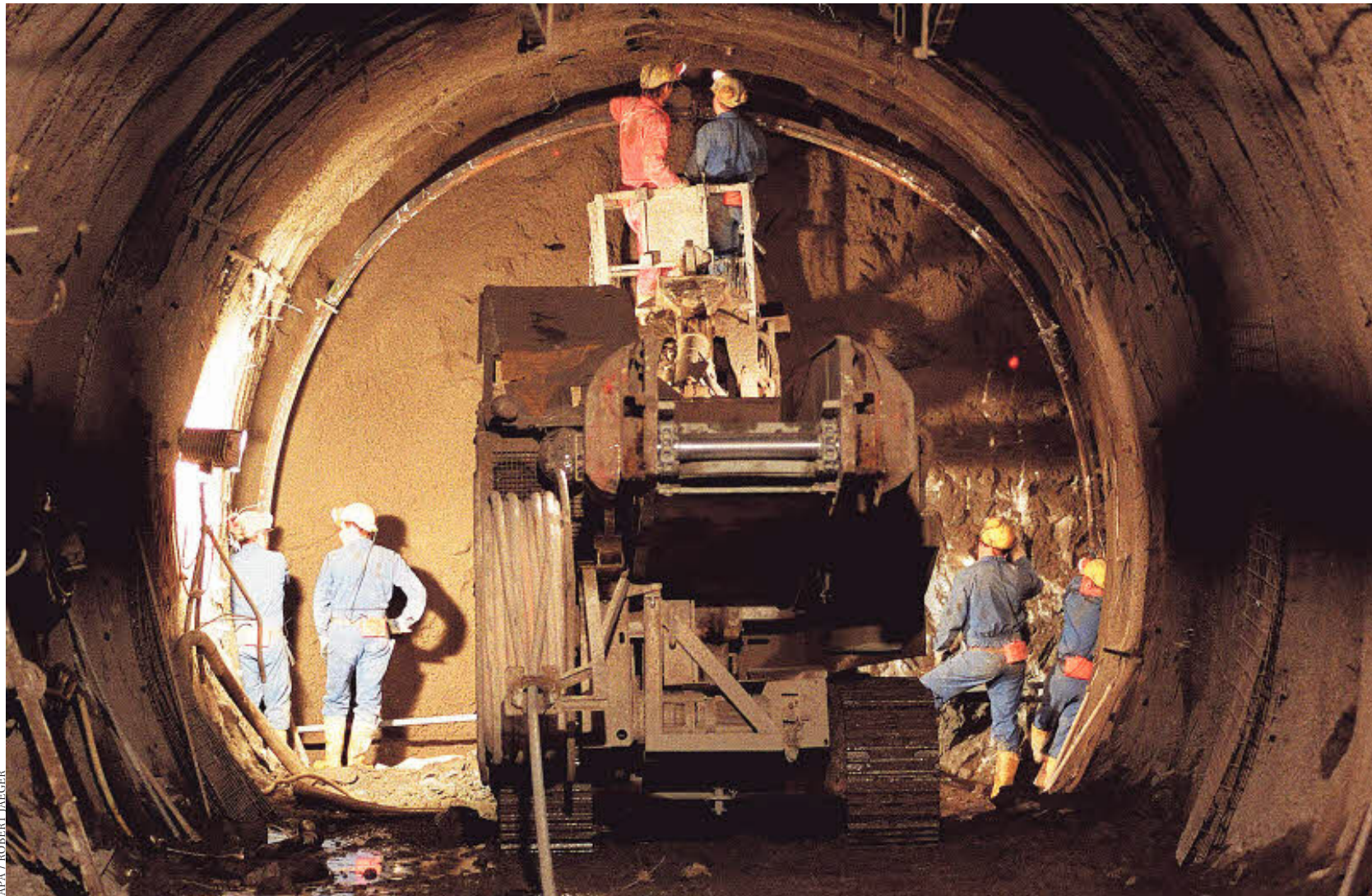
Der Sondierstollen in Mürzzuschlag: Seit 1998 sind hier die Arbeiten eingestellt, für Niederösterreich ist dessen baldige Schließung Grundbedingungen für den neuen Tunnel
